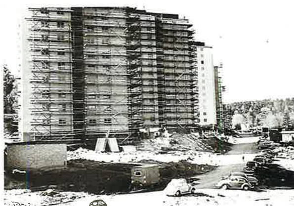
Punkthusen under uppförande 1962.
