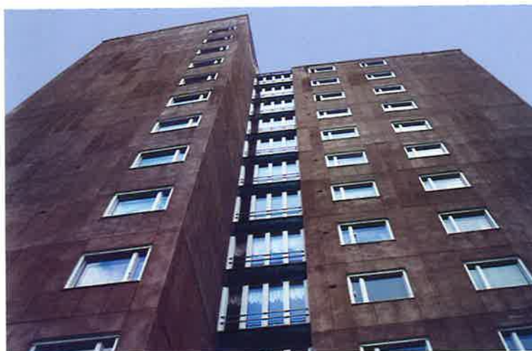
Ett av de punkthus som har sin originalpuls kvar 2001.
