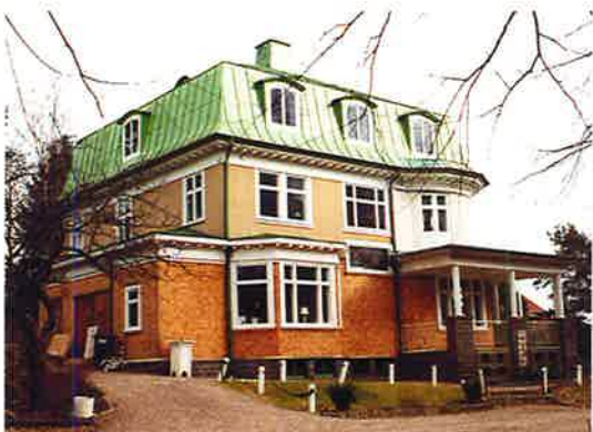
Välbevarad typisk nationalromantisk villa uppförd år 1912.
